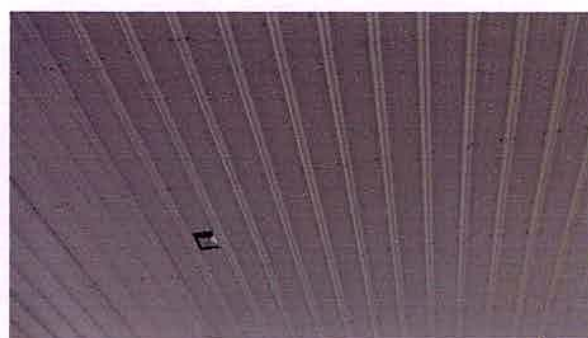
Fig. 12 e 13 – Vista da pista de abastecimento, canaletas e forro do teto em aluzinco.
