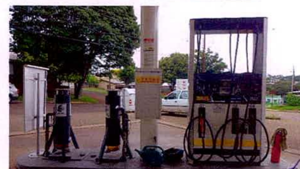
Fotos 10 e 11 – Lateral do Posto e Bomba Sêxtupla com 2 filtros.
