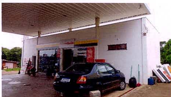
Fig. 12 e 13 – Vista da pista de abastecimento, canaletas e forro do teto em aluzinco.
