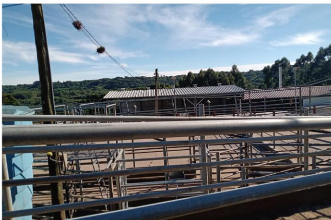
Inspeção da área externa
