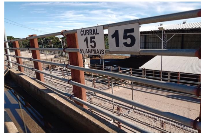
Inspeção da área externa
