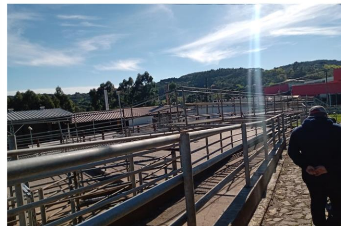
Inspeção da área externa
