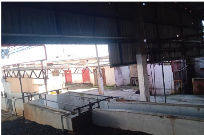
Inspeção da área externa
