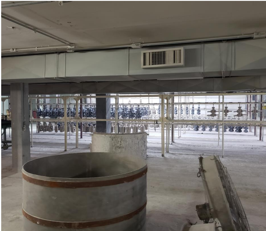
REVESTIMENTO EM CERÂMICA
