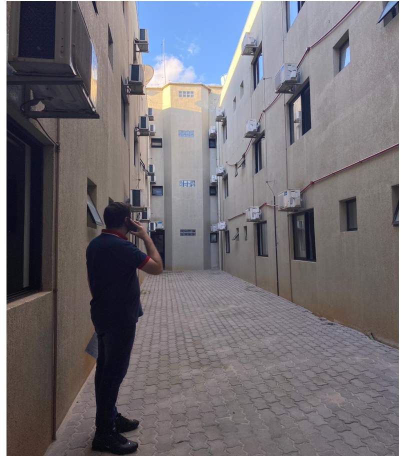
Vista do interior do imóvel
